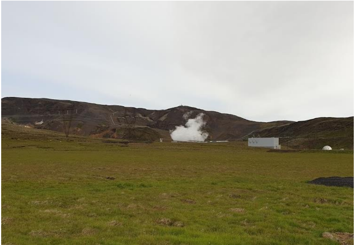
Mynd 5.1. Horft yfir fyrirhugað framkvæmdasvæði vetnis- og metangasverksmiðju í Jarðhitagarði ON.
